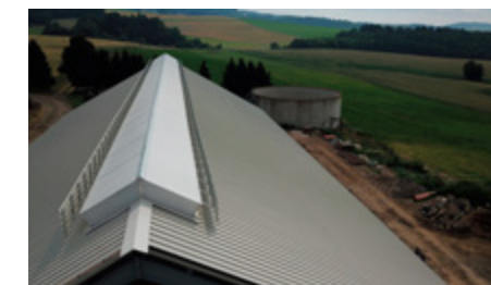
Montáž ocelové konstrukce
