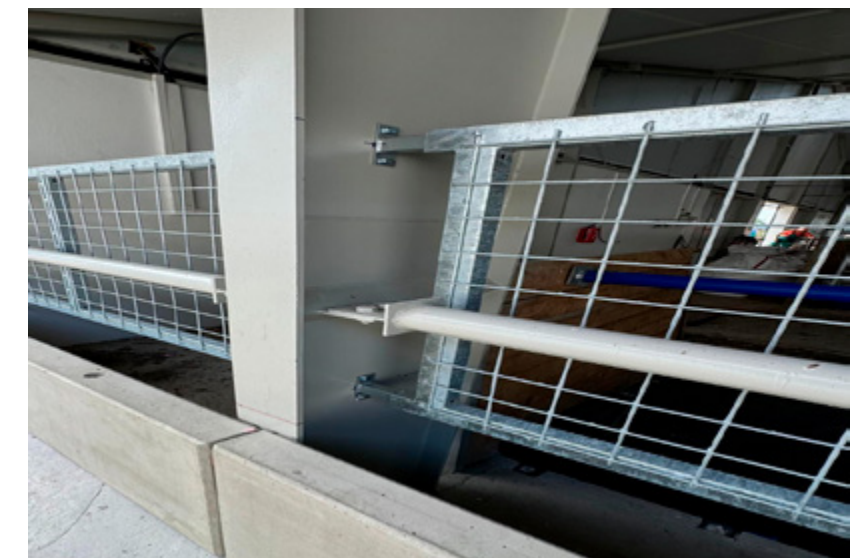
Detail kotvení kari sítě
