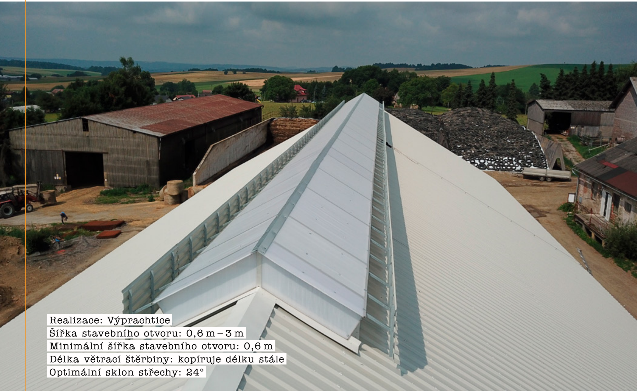
Schéma hřebenové větrací štěrbinu bez regulace – sedlové zakrytí
