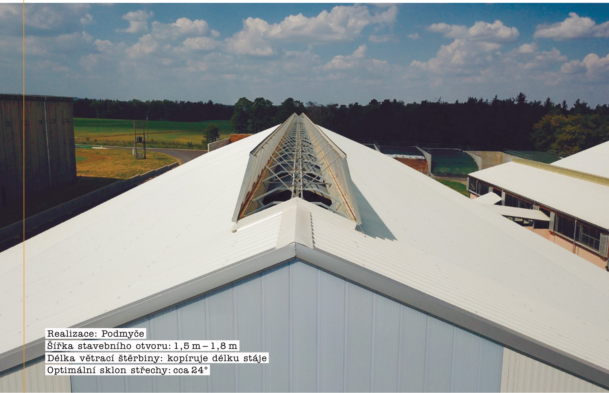
Schéma křídlové štěrby dvoukřídlé ovládané elektropohonem
