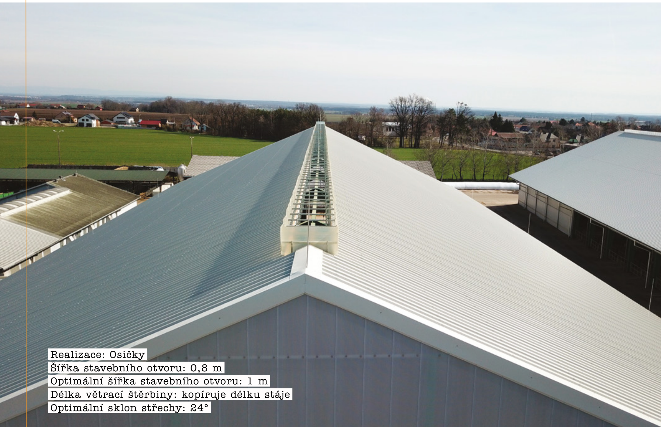
Schéma hřebenové větrací štěrbin otevřené H
