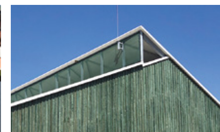
Větrací hřebenová štěrbina pultové střechy (zakrytí možné svinovací plachtou nebo protiprůvanovou sítí)
