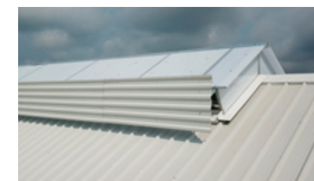
Montáž bočního deflektoru
