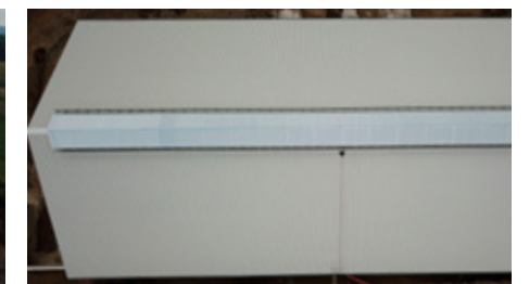
Montáž polykarbonátové výplně
