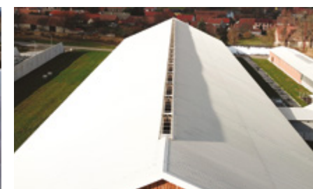
Hřebenová štěrbiná otevřená H v délce 80 cm
