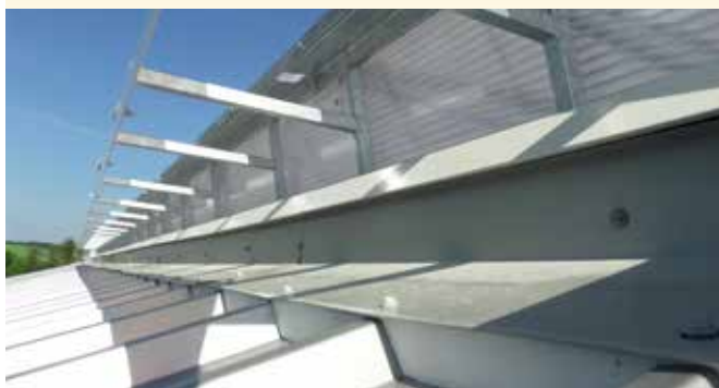
Plechování štěrbin s těsnícím profilem
