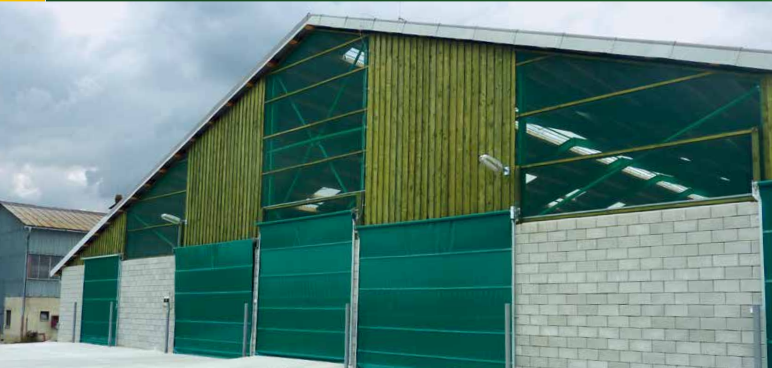
Použití protiprůvanové sítě ve štítě
