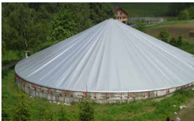
Finální podoba zastřešené jímky
